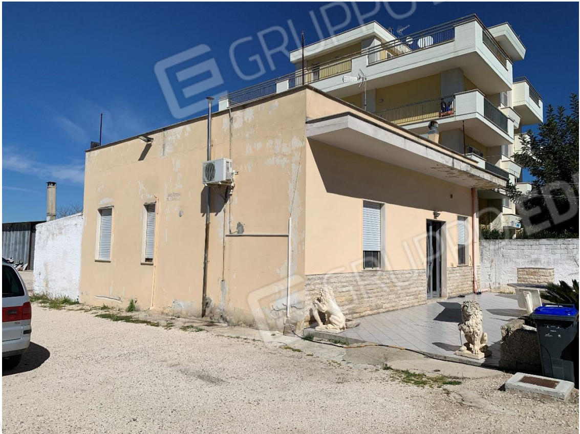
Foto 4. Vista fabbricato lato Sud - Est
