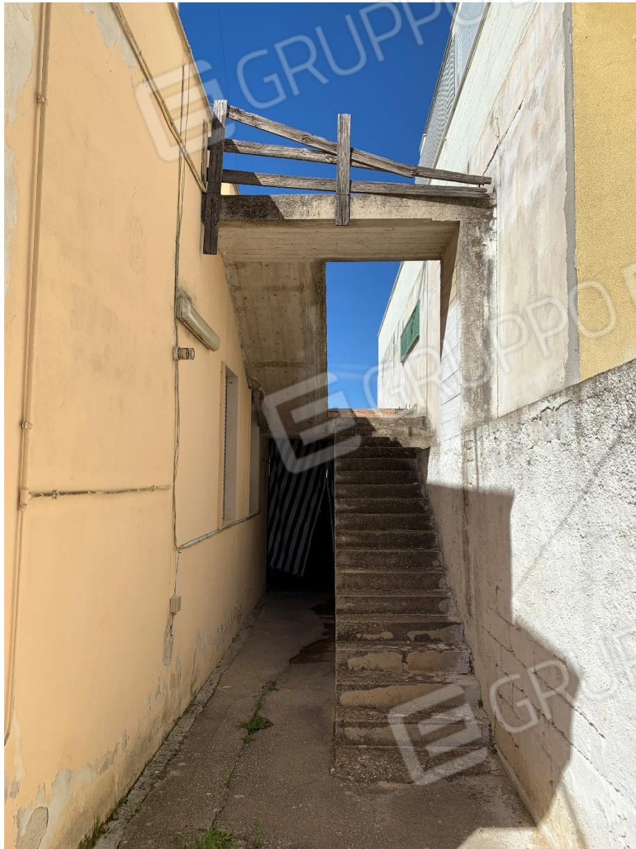
Foto 6. Dettaglio scala d'accesso lastrico solare lato Nord
