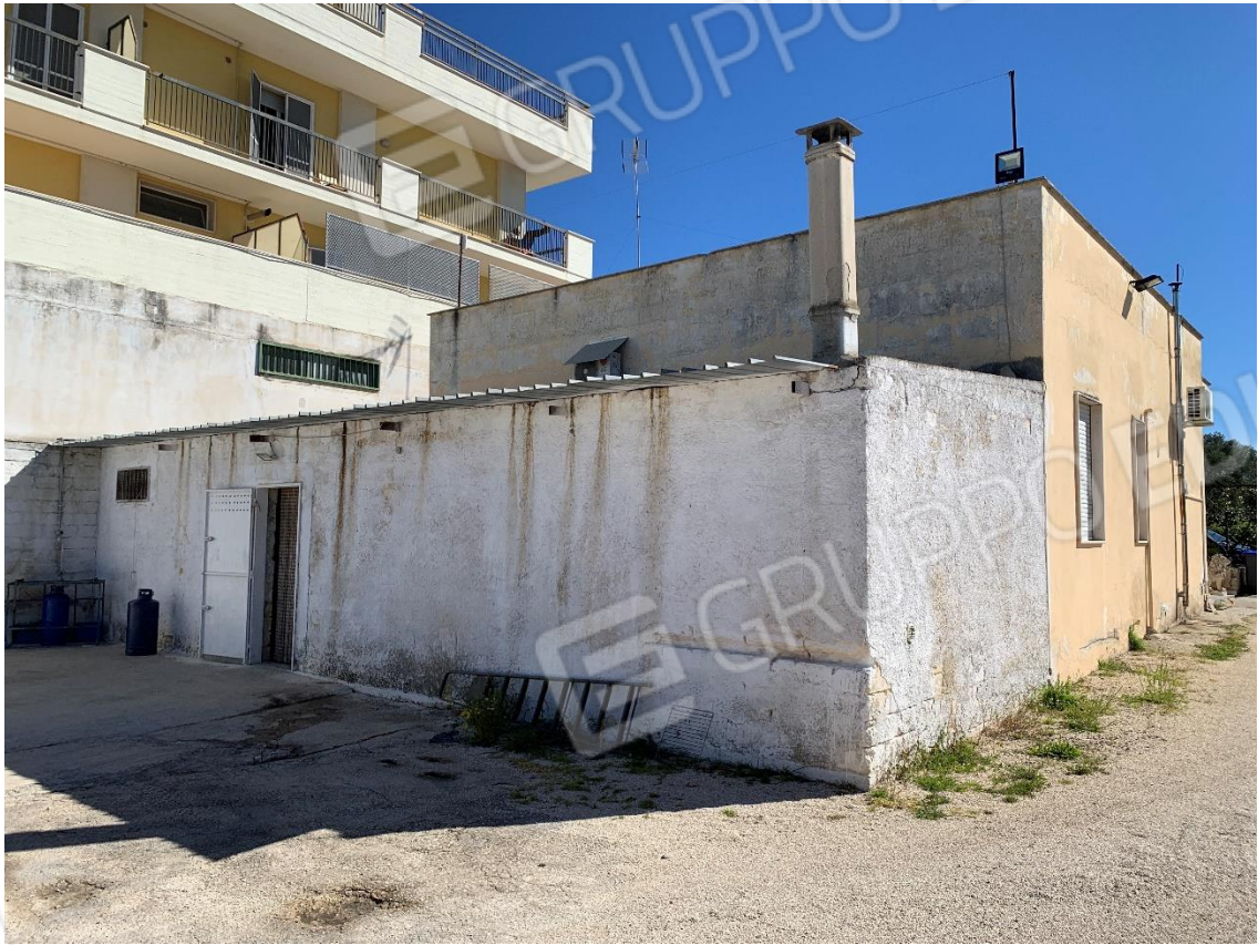
Foto 5. Vista fabbricato lato Ovest
