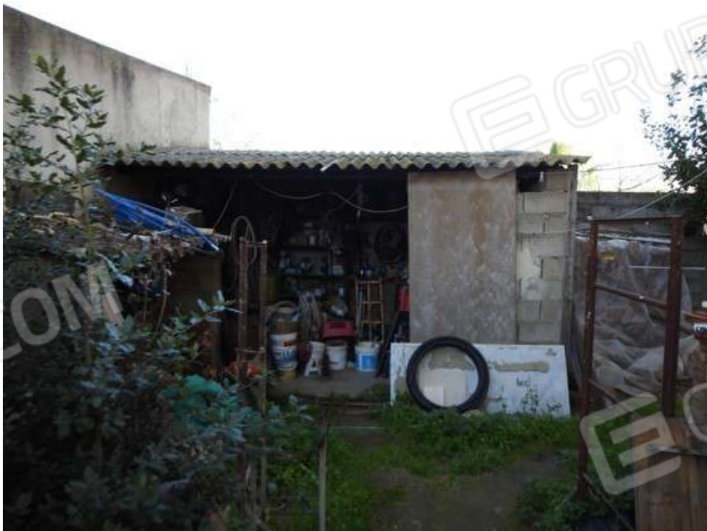
Fotografia F.34 - 034_Tettoia
