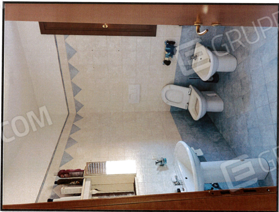
Foto n. 6: Vista bagno al piano secondo.
