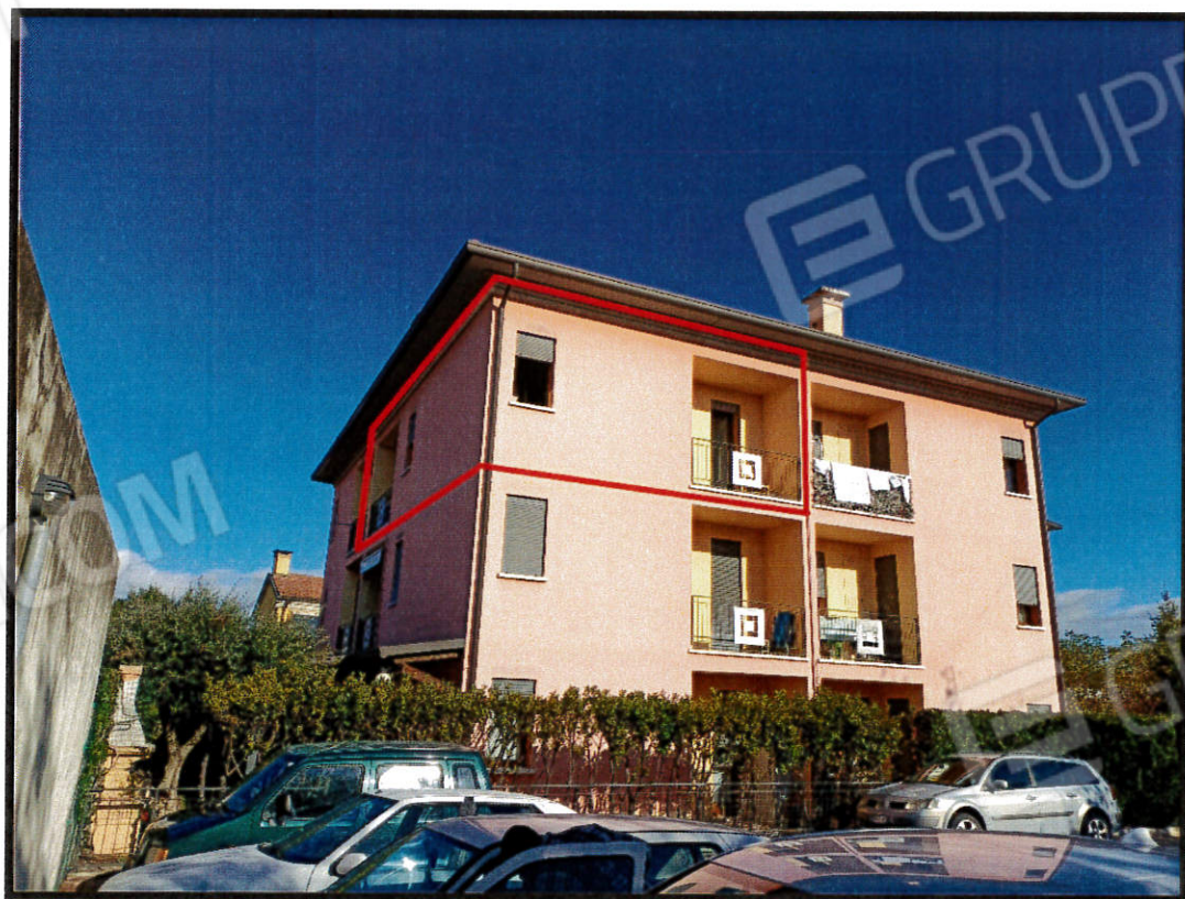
Foto n. 2: Vista appartamento al piano secondo, prospetto Sud.
