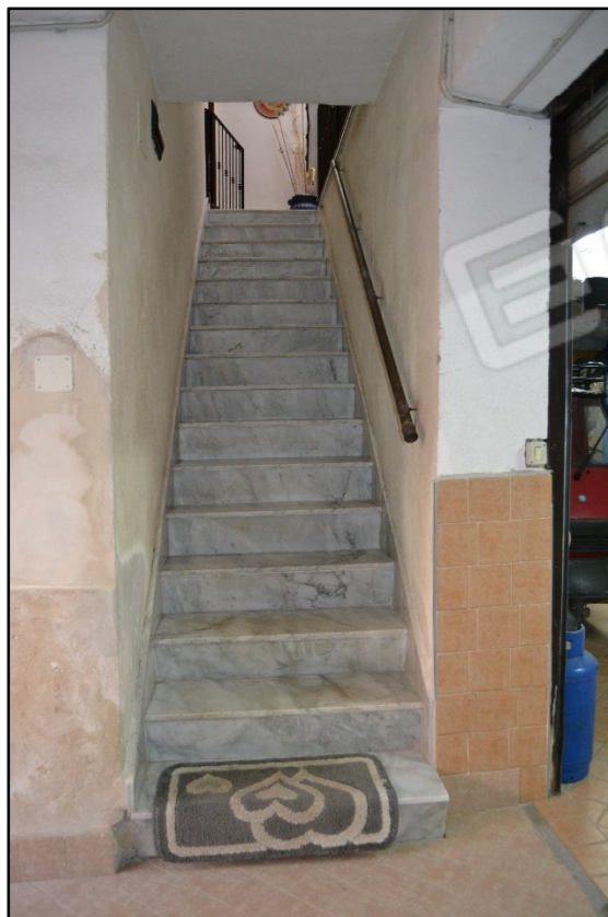
Foto 3 (scala di accesso al primo piano)
