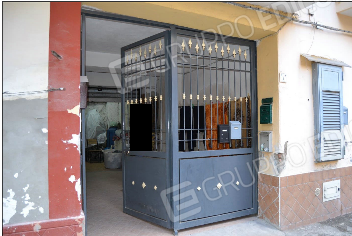
Foto 1 (portone di ingresso su via G. D'Annunzio)
