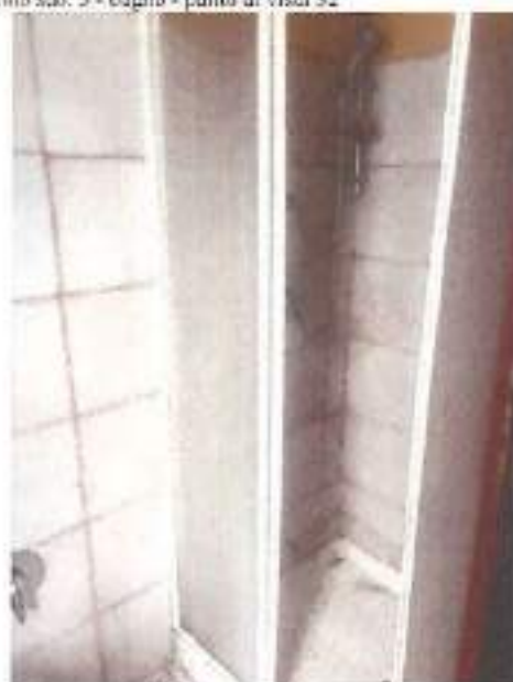
Magazzino sub. 5 - bagno - punto di vista 32
