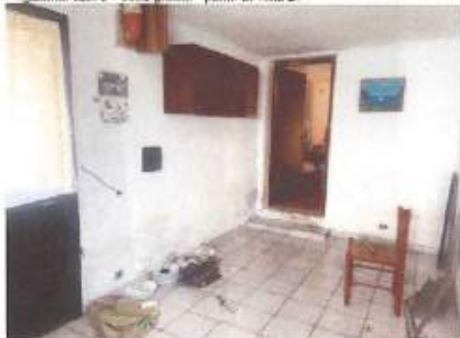
Magazzino sub. 5 - zona giorno - punto di vista 27
