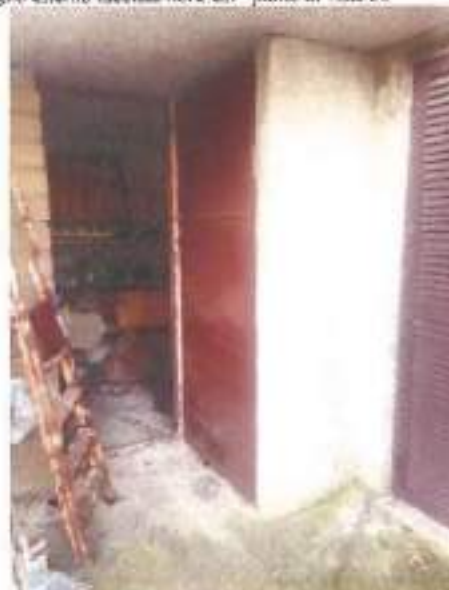
Ripostiglio esterno facciata nord-est - punto di vista 36
