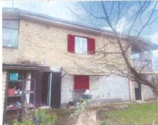
Facciata lato nord-est - punto di vista 4
