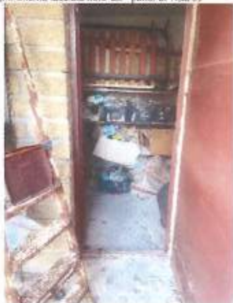
Ripostiglio esterno facciata nord-est - punto di vista 35
