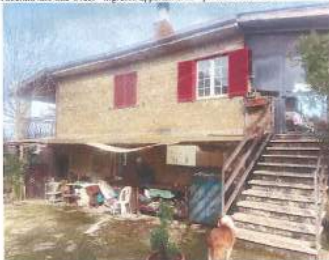
Facciata lato sud-ovest - ingresso appartamento - punto di vista 2
