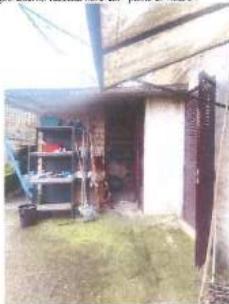
Ripostiglio esterno facciata nord-est - punto di vista 34
