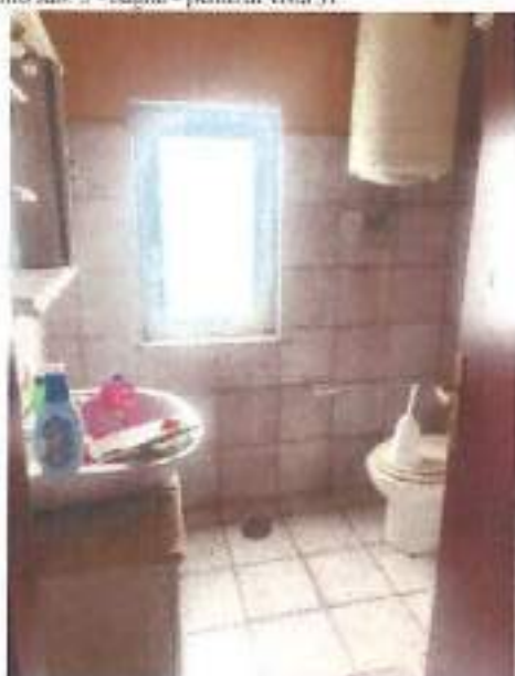
Magazzino sub. 5 - bagno - punto di vista 31
