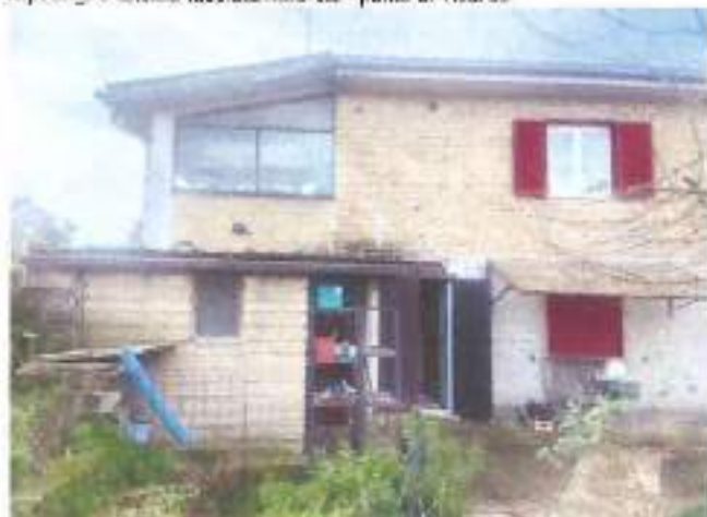
Ripostiglio esterno facciata nord-est - punto di vista 33
