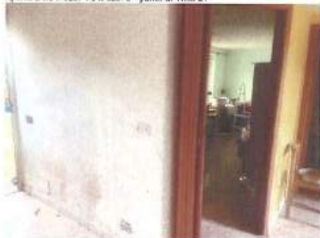
Apertura tra il sub. 4 e il sub. 5 - punto di vista 21
