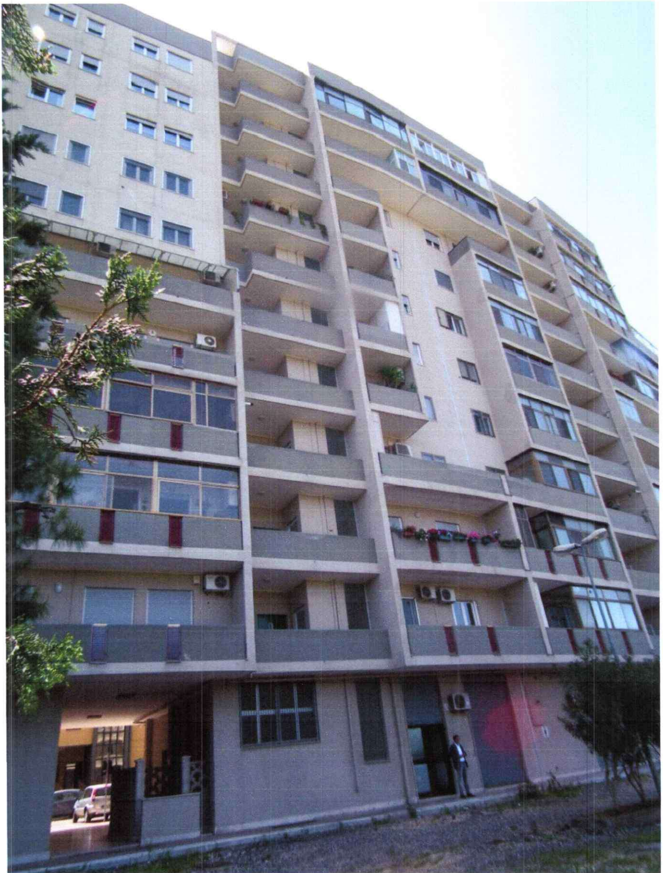
Foto 2: vista dal cortile su via s. Tommaso d'Aquino
