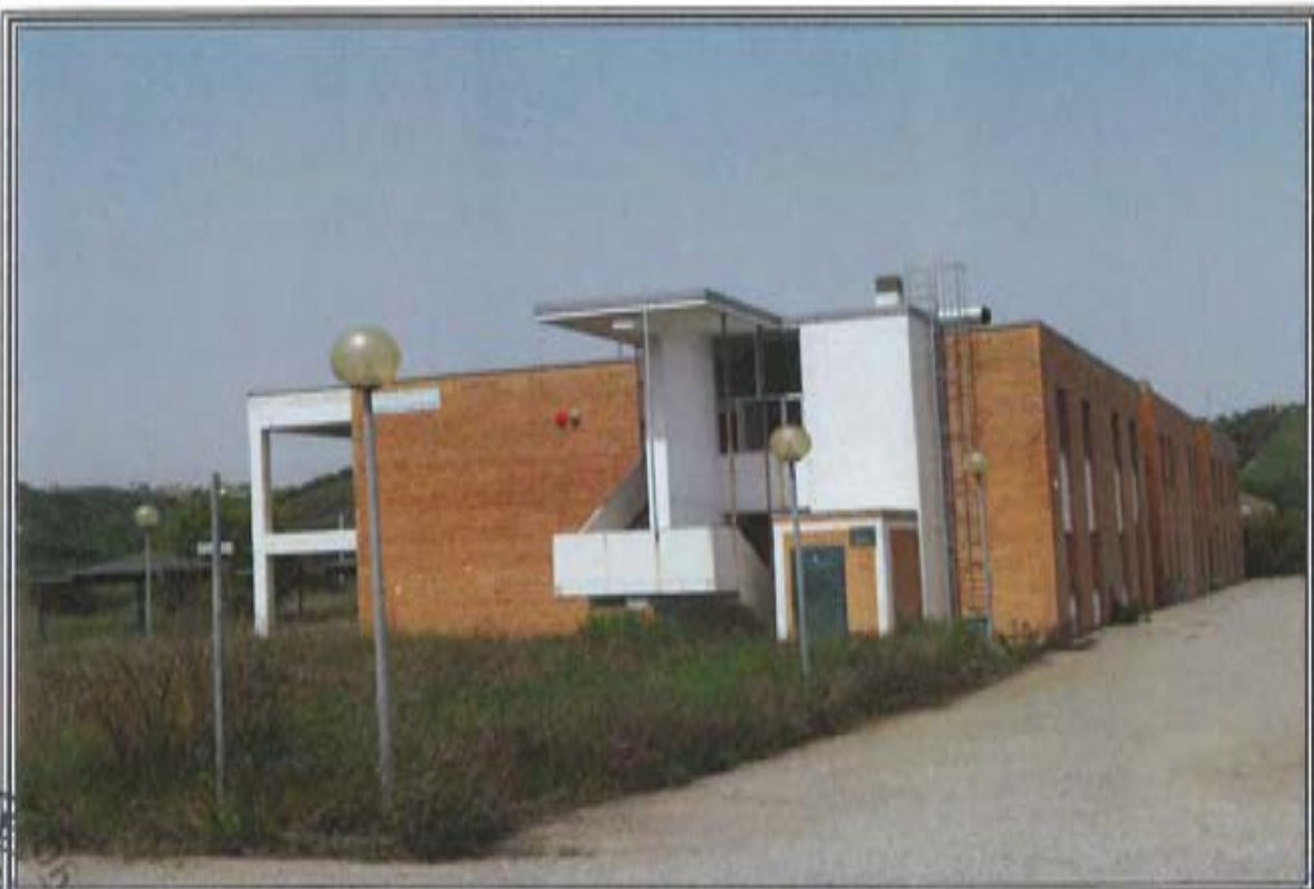
FOTOGRAFIA n. 1: Vista Esterna Area Servizi Generali (SG)
