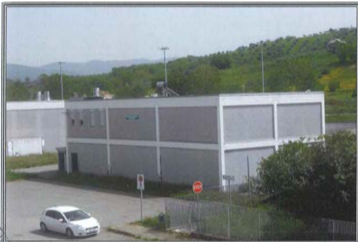
FOTOGRAFIA n. 1: Vista Esterna Area Manutenzione e Pulizie (MP)
