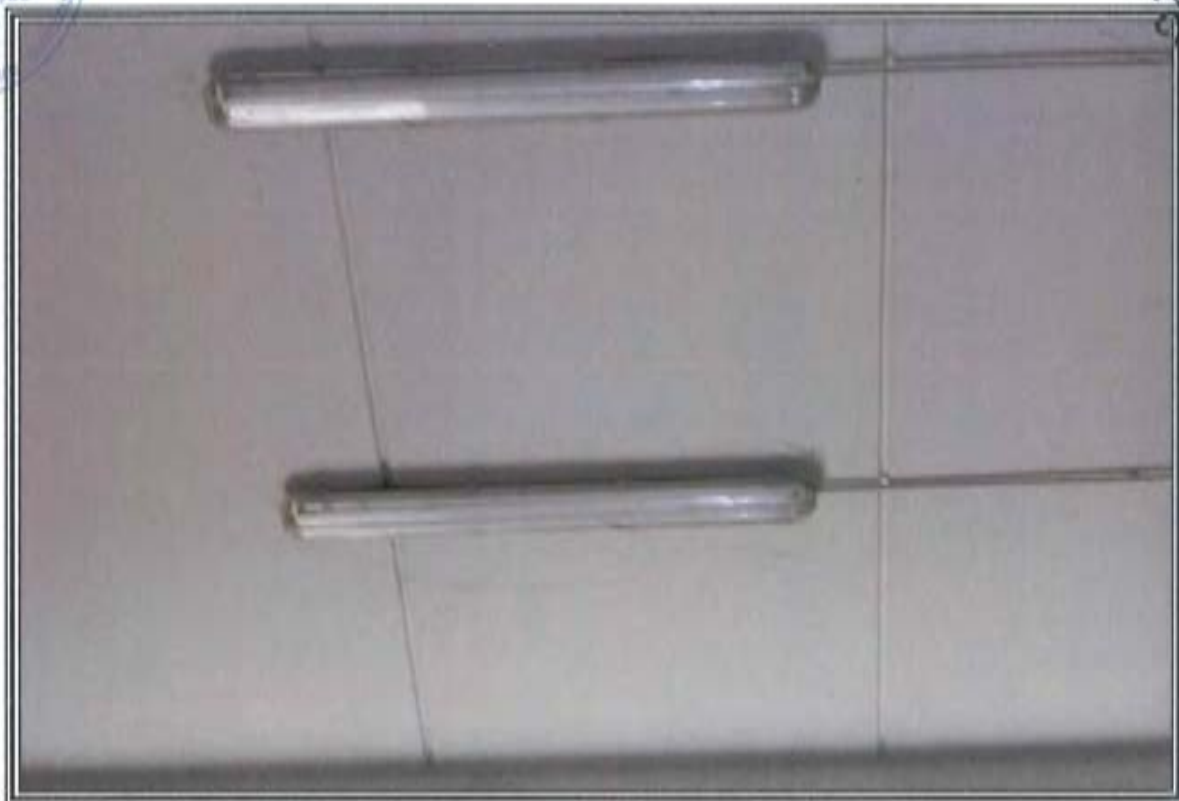
FOTOGRAFIA n. 12: Vista Interna Area Manutenzione e Pulizie (MP)
