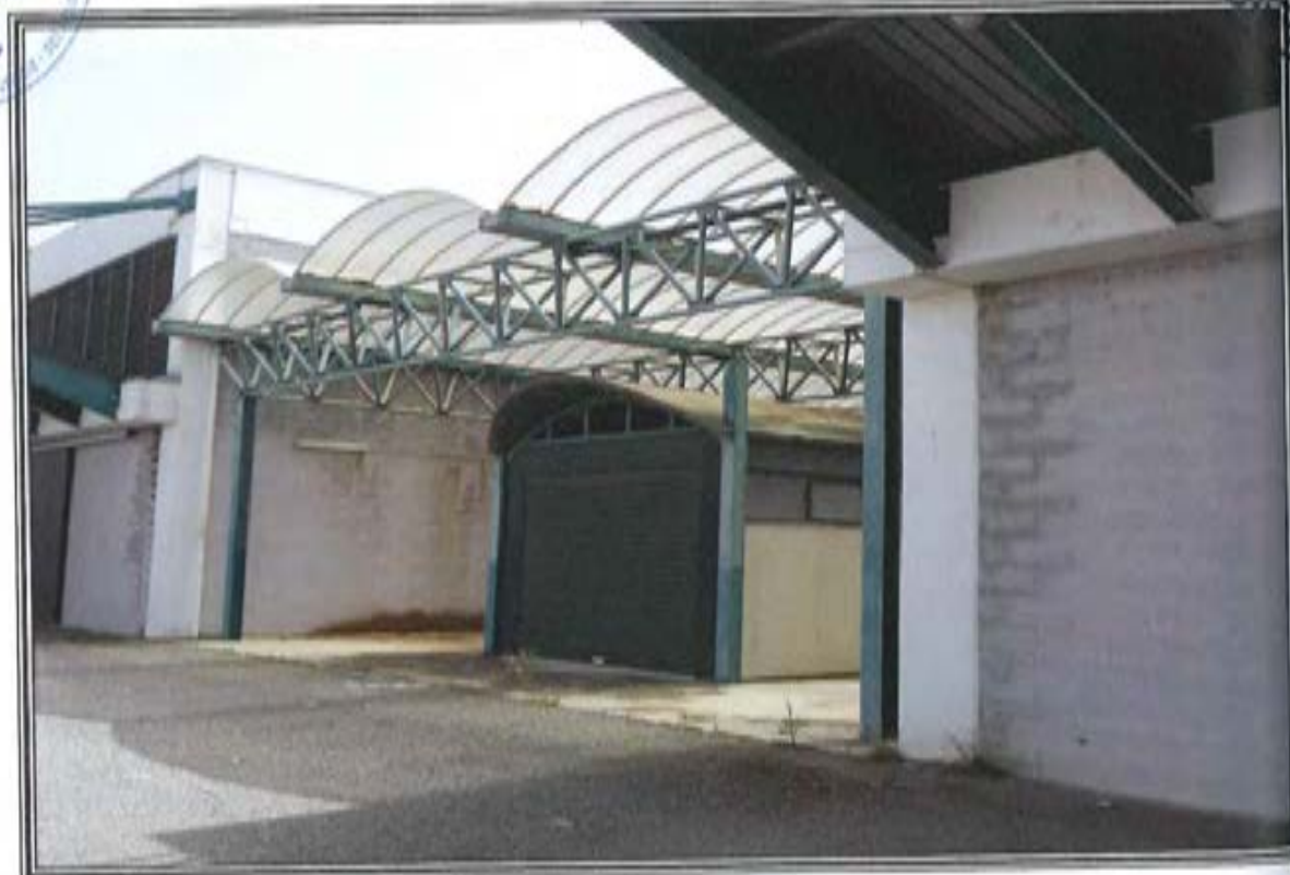
FOTOGRAFIA n. 4: Vista Esterna Area Mercato Altre Merceologie (AM)
