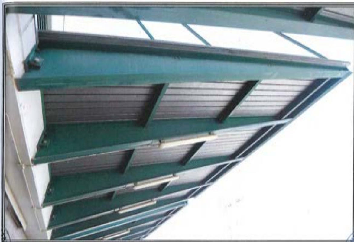
FOTOGRAFIA n. 9: Vista Esterna Area Mercato Altre Merceologie (AM)
