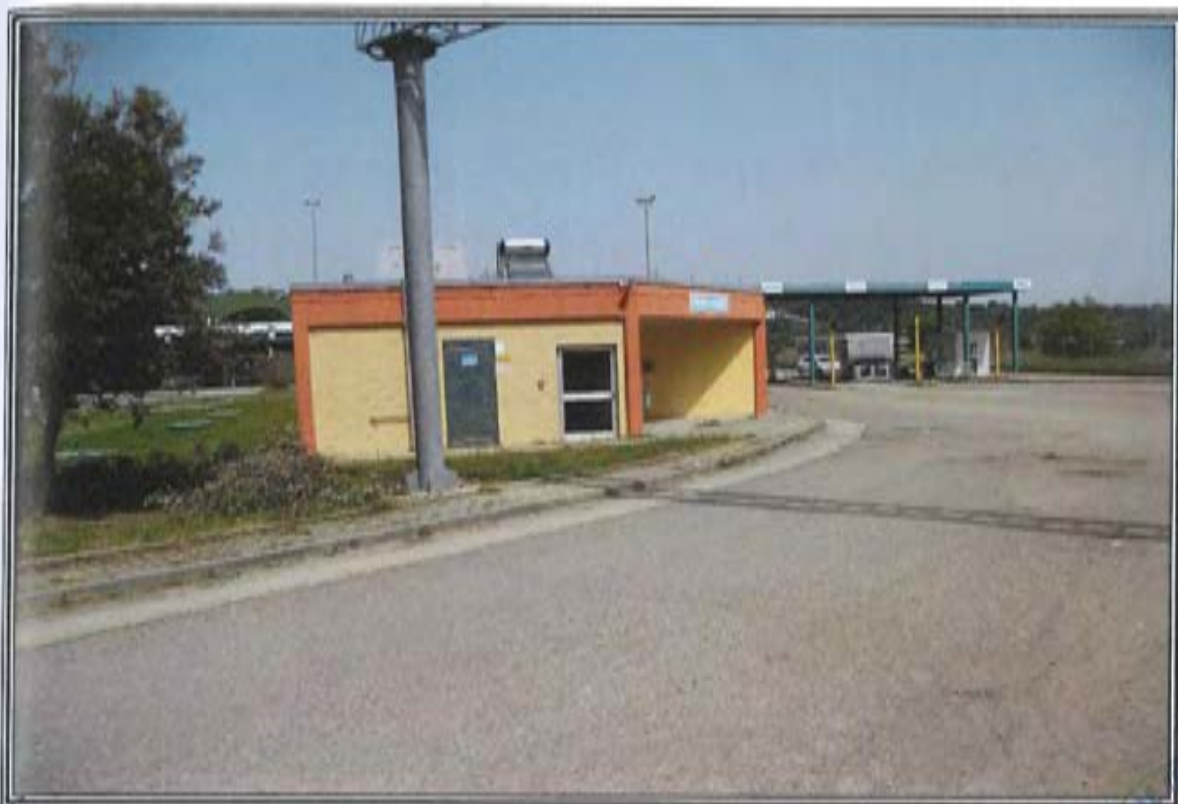
FOTOGRAFIA n. 1: Vista Esterna Centro Ingressi (CI)
