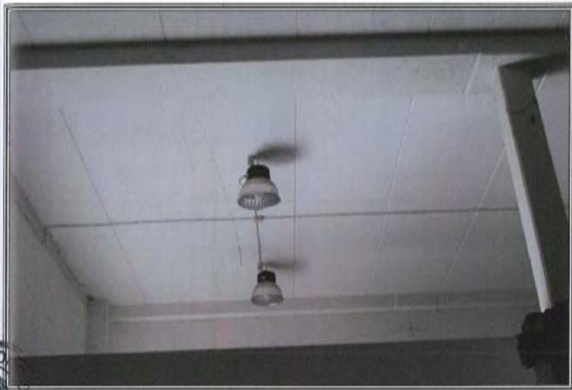
FOTOGRAFIA n. 13: Vista Interna Area Manutenzione e Pulizie (MP)
