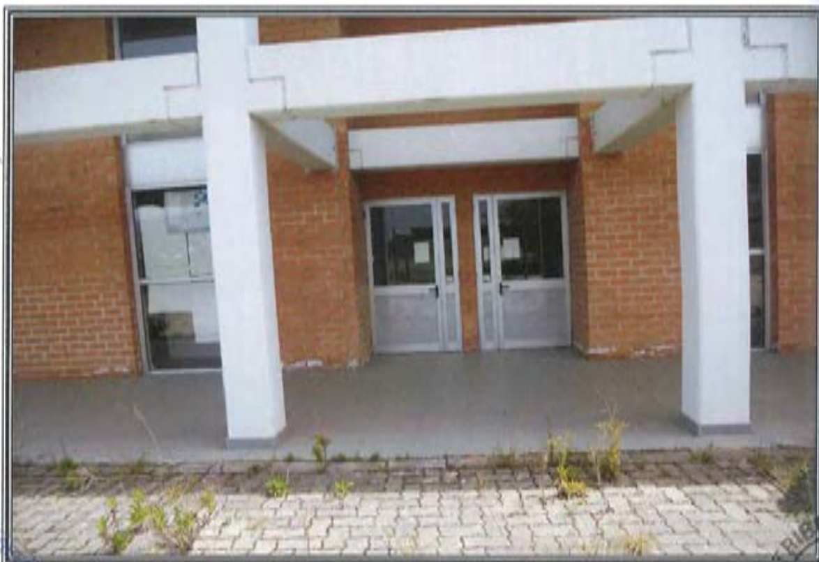
FOTOGRAFIA n. 7: Vista Esterna Area Servizi Generali (SG)
