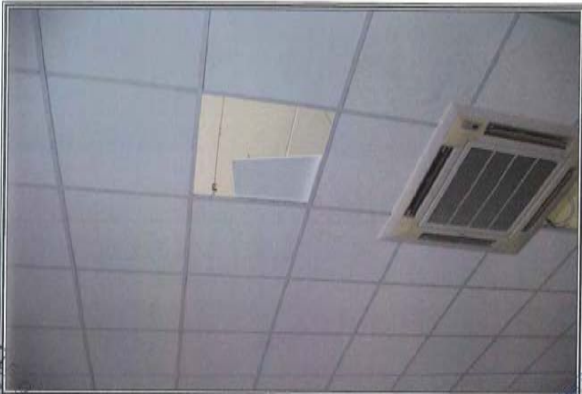
FOTOGRAFIA n. 21: Vista Interna Area Servizi Generali (SG)
