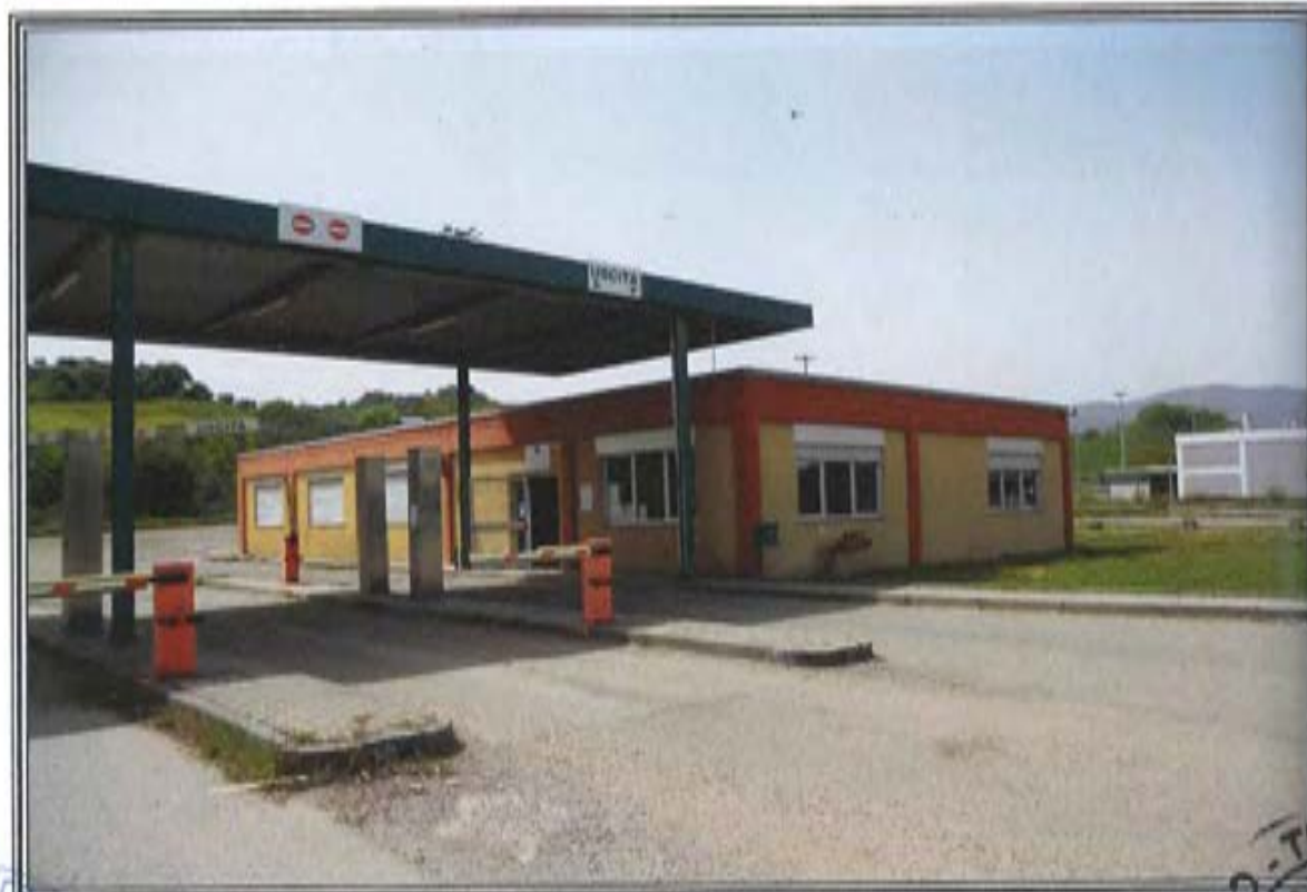
FOTOGRAFIA n. 3: Vista Esterna Centro Ingressi (CI)
