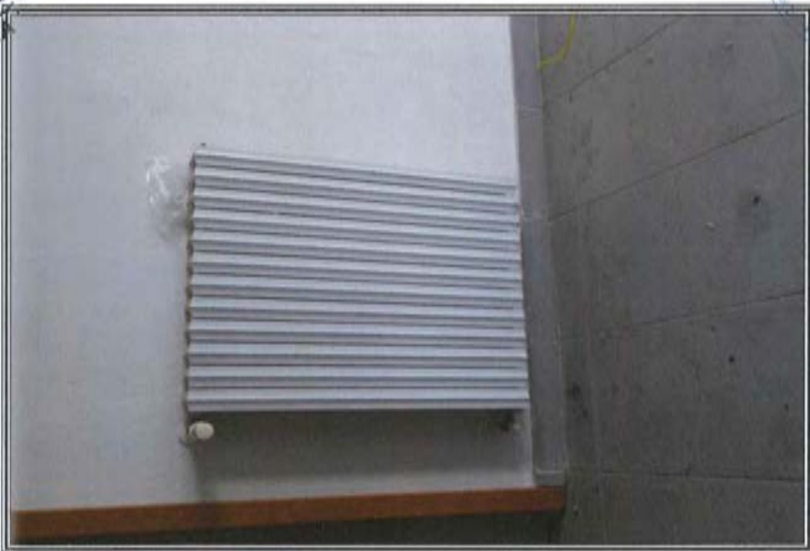
FOTOGRAFIA n. 6: Vista Interna Area Manutenzione e Pulizie (MP)
