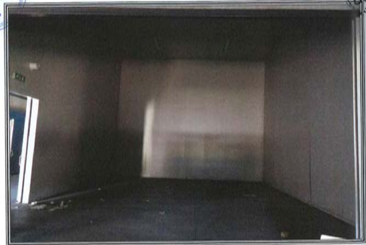
FOTOGRAFIA n. 8: Vista Interna Magazzini Frigoriferi (MF)
