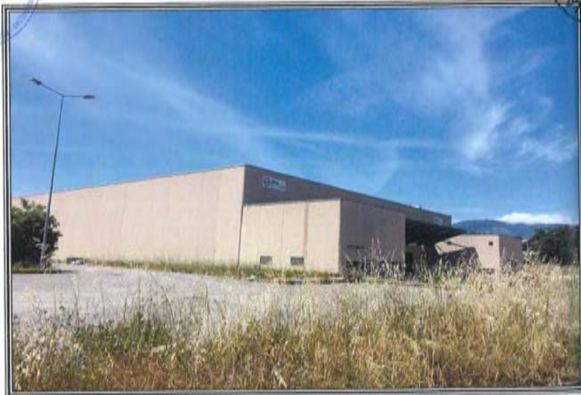
FOTOGRAFIA n. 4: Vista Esterna Magazzini Frigoriferi (MF)
