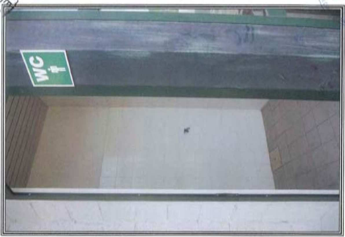
FOTOGRAFIA n. 18: Vista Interna Area Mercato Ortofrutticolo (MO)
