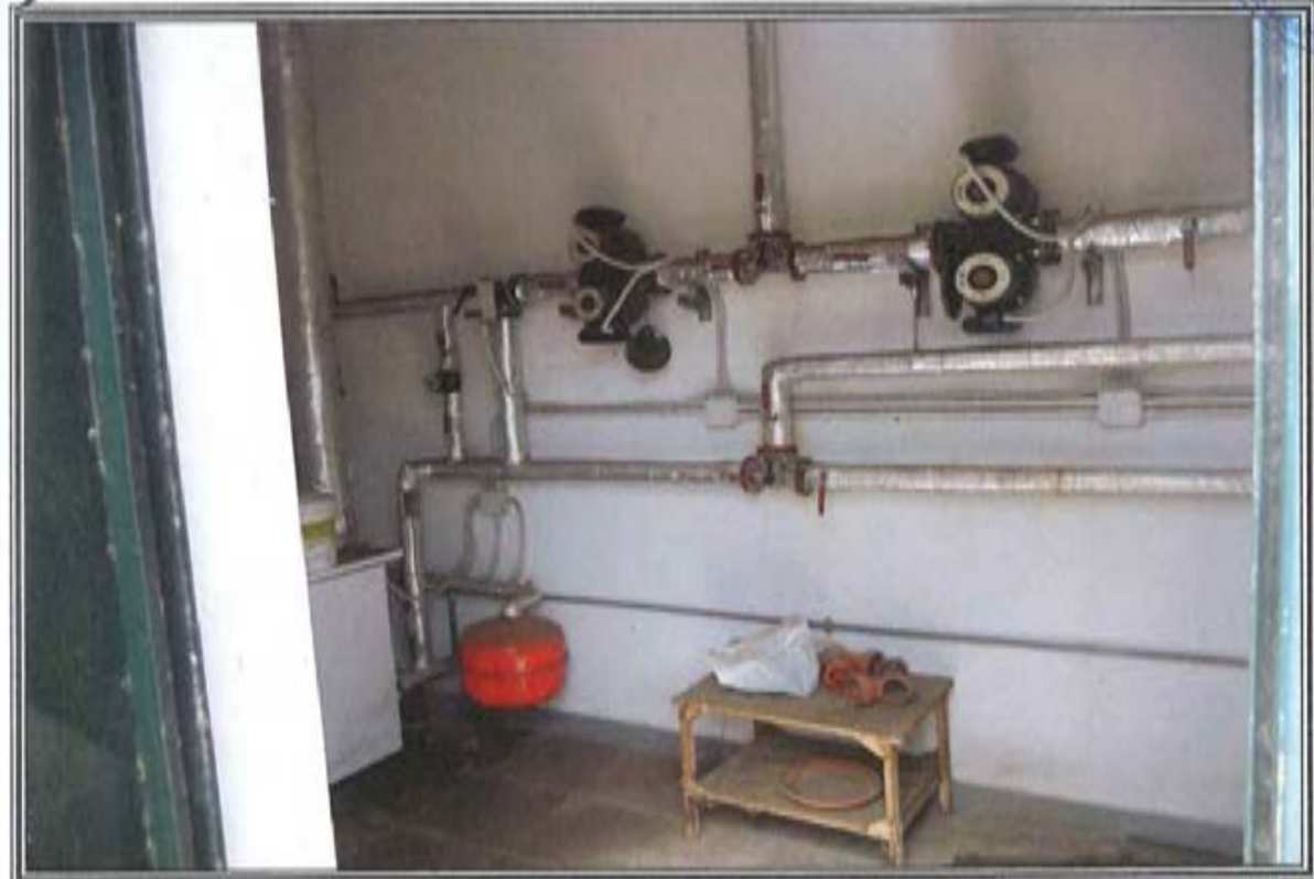
FOTOGRAFIA n. 10: Vista Interna Centro Ingressi (CI)
