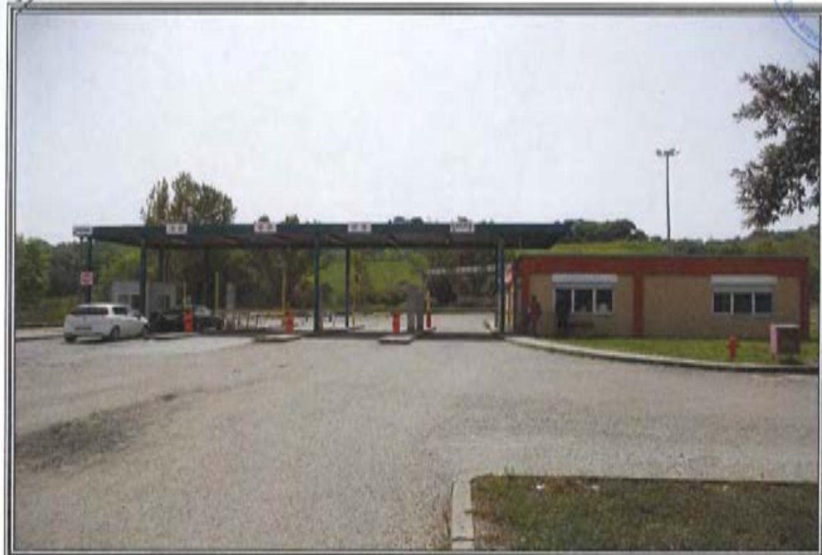
FOTOGRAFIA n. 2: Vista Esterna Centro Ingressi (CI)
