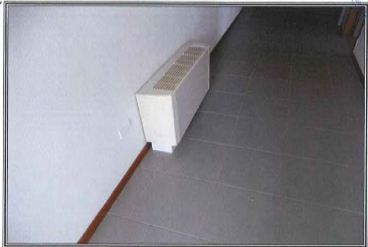
FOTOGRAFIA n. 18: Vista Interna Area Servizi Generali (SG)
