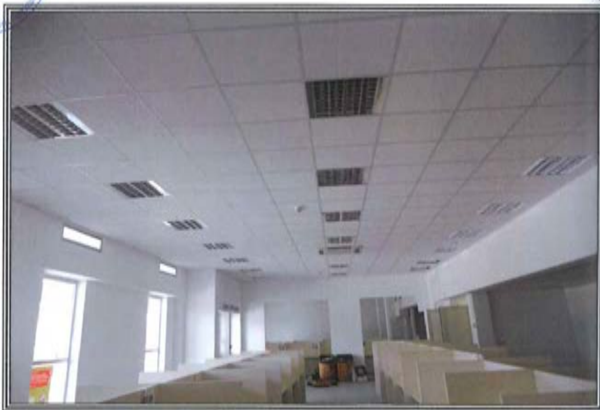
FOTOGRAFIA n. 20: Vista Interna Area Servizi Generali (SG)
