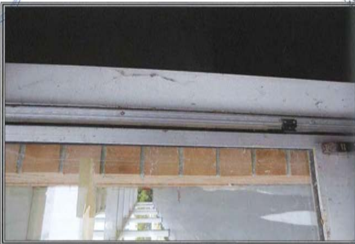
FOTOGRAFIA n. 8: Vista Esterna Area Servizi Generali (SG)
