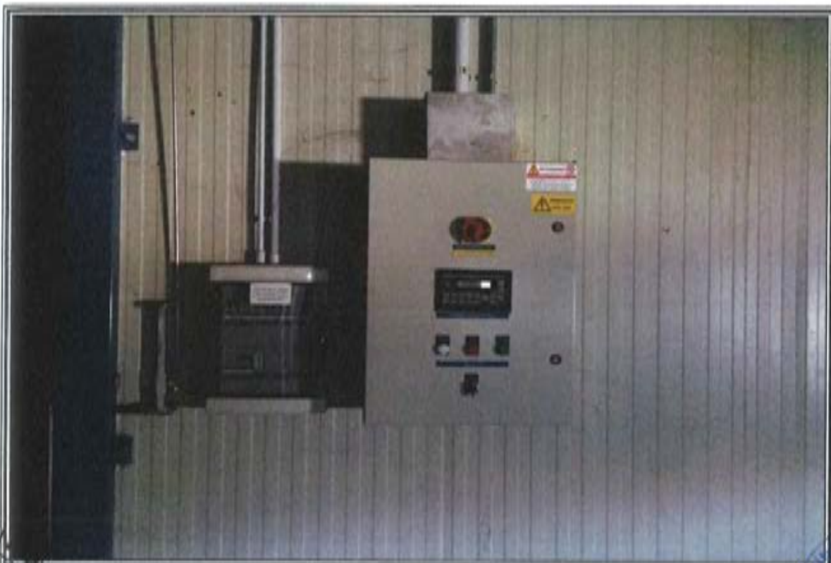
FOTOGRAFIA n. 9: Vista Interna Magazzini Frigoriferi (MF)
