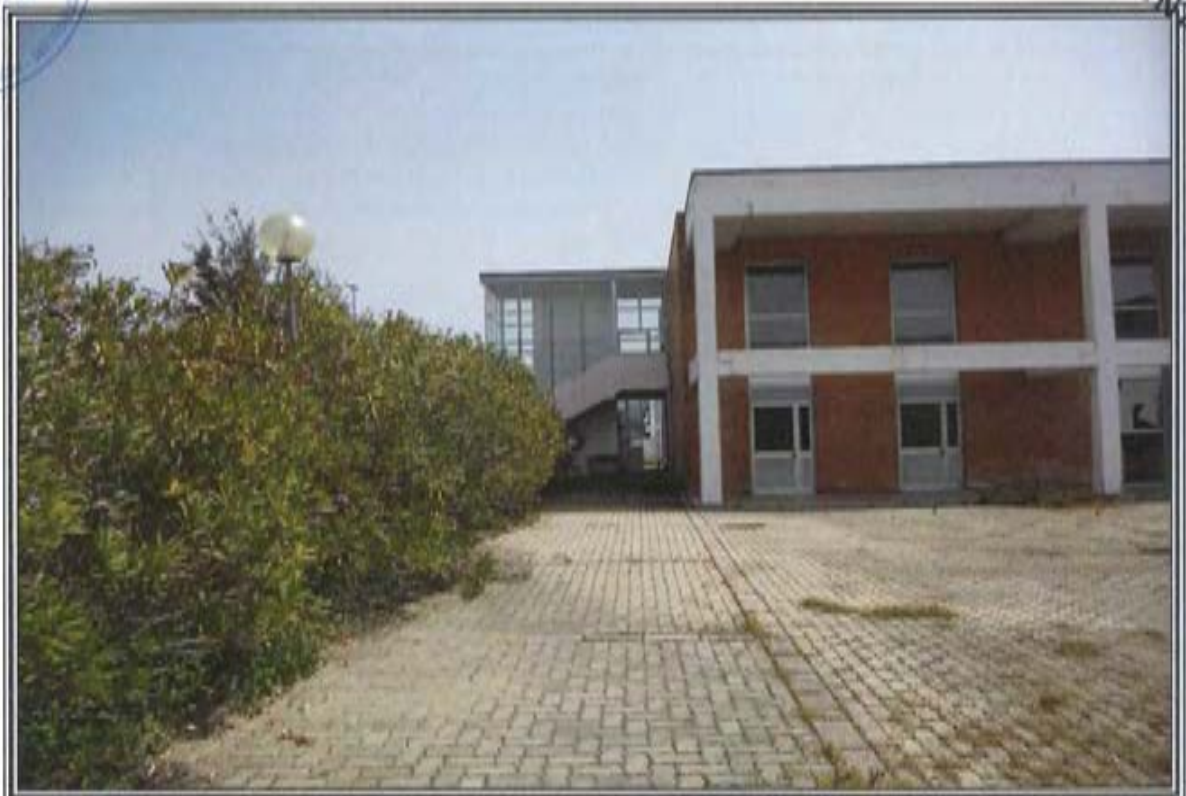
FOTOGRAFIA n. 4: Vista Esterna Area Servizi Generali (SG)
