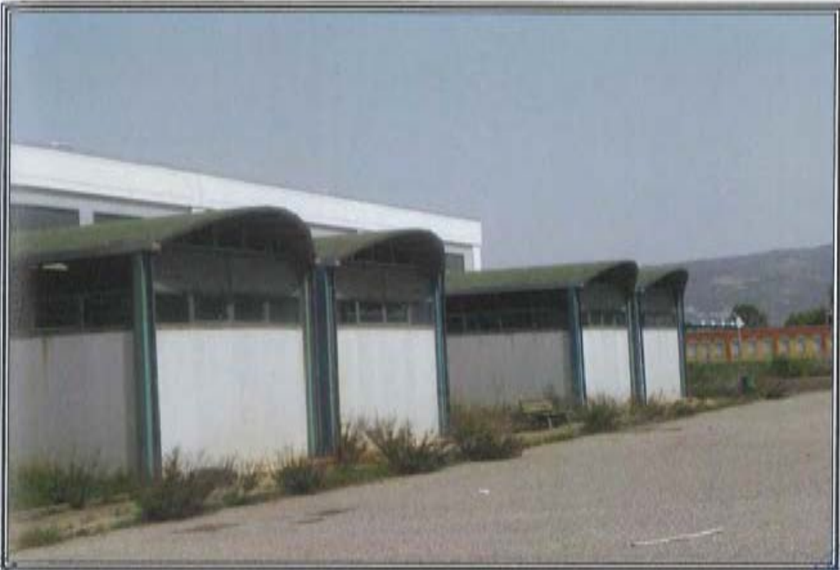
FOTOGRAFIA n. 5: Vista Esterna Area Mercato Altre Merceologie (AM)
