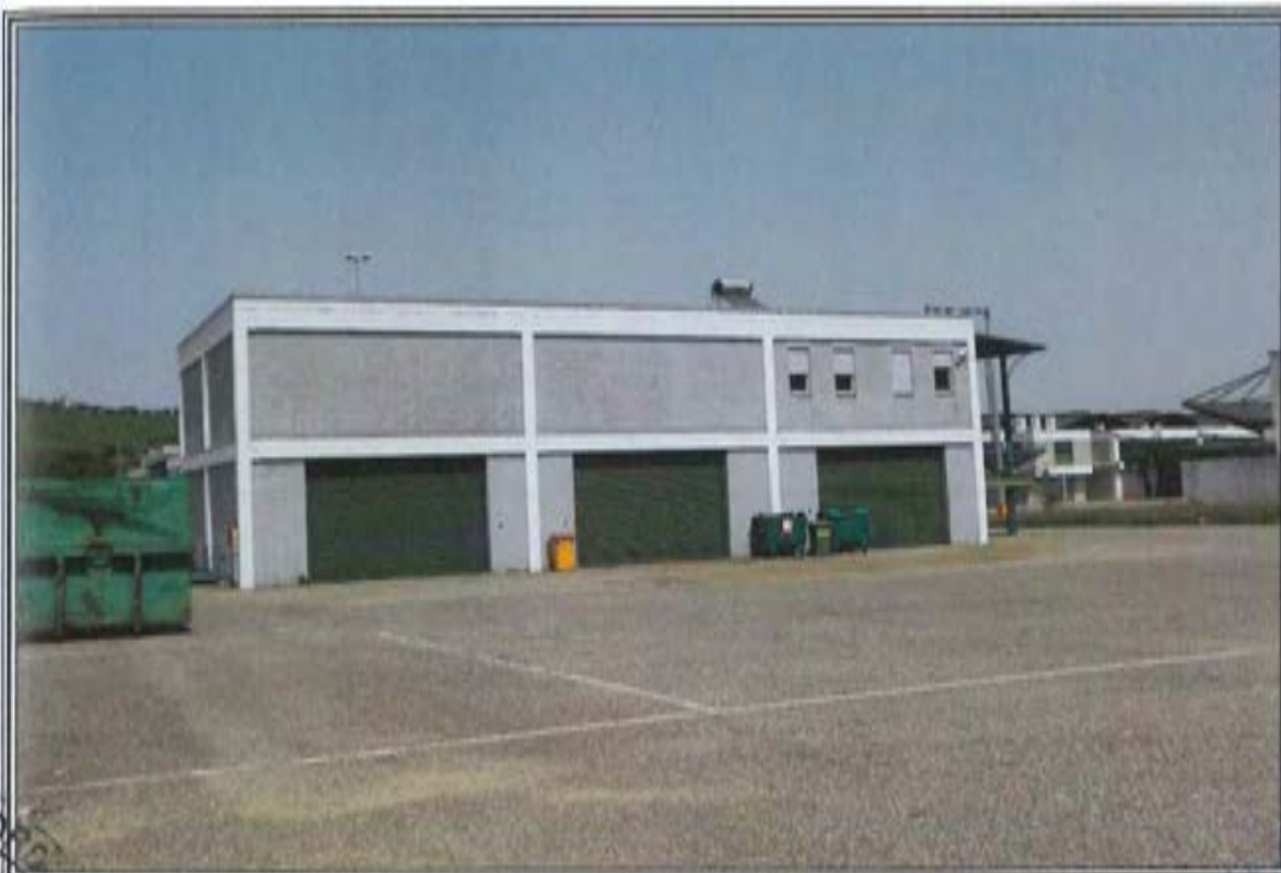
FOTOGRAFIA n. 9: Vista Esterna Area Manutenzione e Pulizie (MP)
