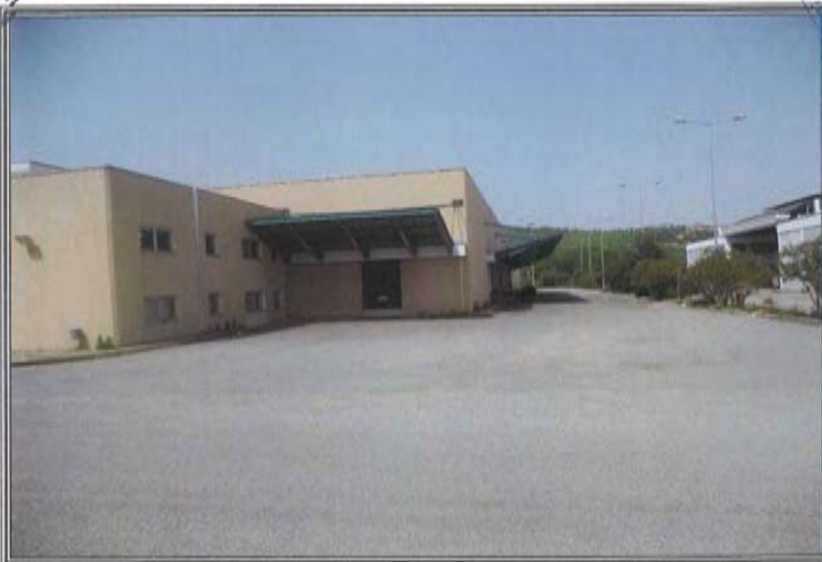
FOTOGRAFIA n. 2: Vista Esterna Magazzini Frigoriferi (MF)
