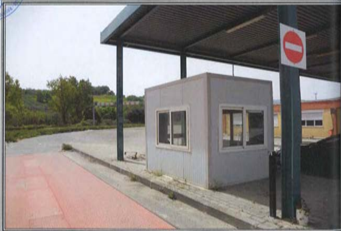
FOTOGRAFIA n. 12: Vista Esterna Centro Ingressi (CI)
