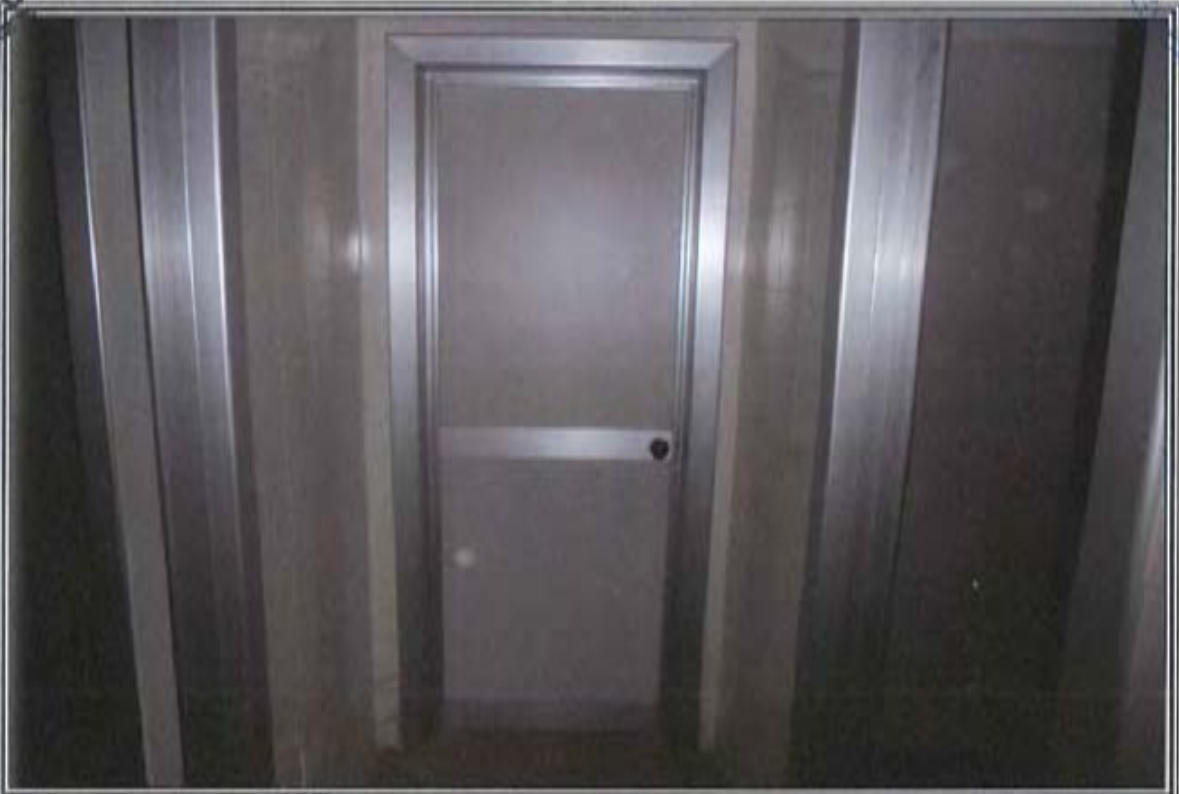
FOTOGRAFIA n. 14: Vista Interna Area Mercato Altre Merceologie (AM)
