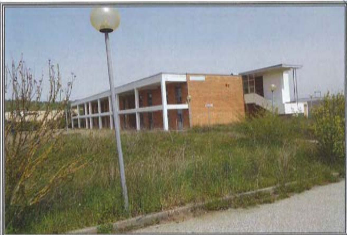
FOTOGRAFIA n. 2: Vista Esterna Area Servizi Generali (SG)
