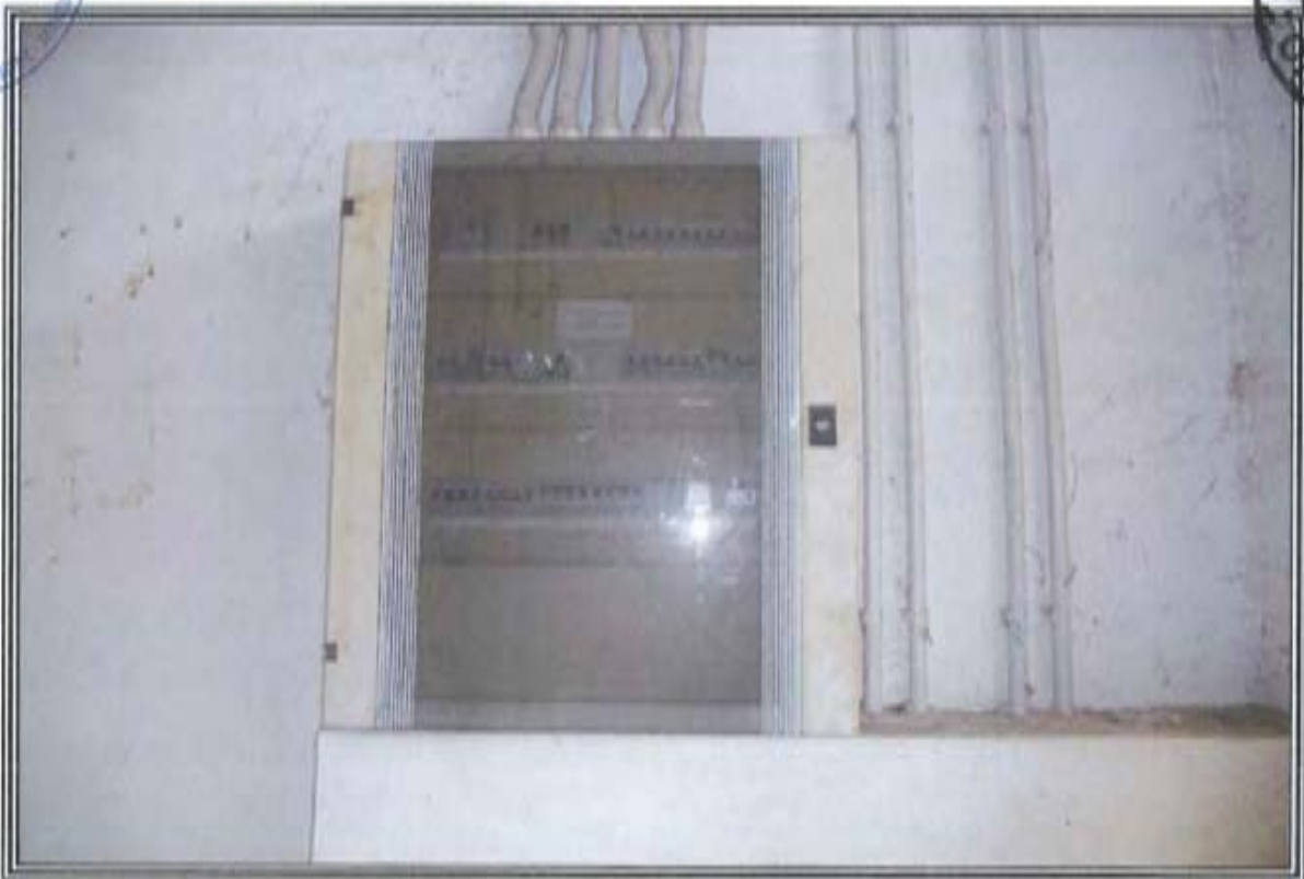
FOTOGRAFIA n. 20: Vista Interna Area Mercato Ortofrutticolo (MO)
