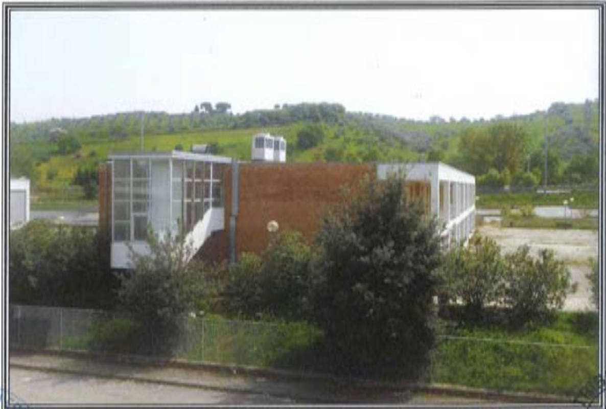
FOTOGRAFIA n. 3: Vista Esterna Area Servizi Generali (SG)
