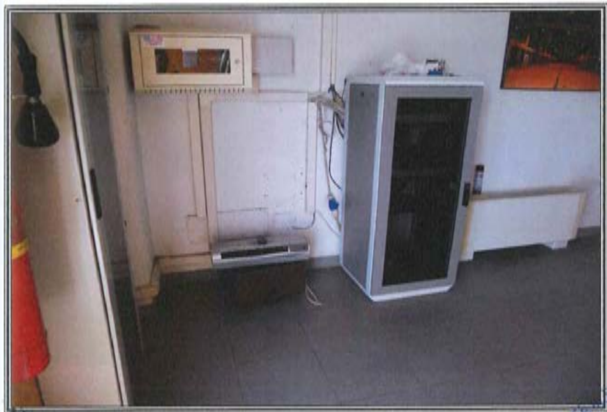
FOTOGRAFIA n. 9: Vista Interna Centro Ingressi (CI)
