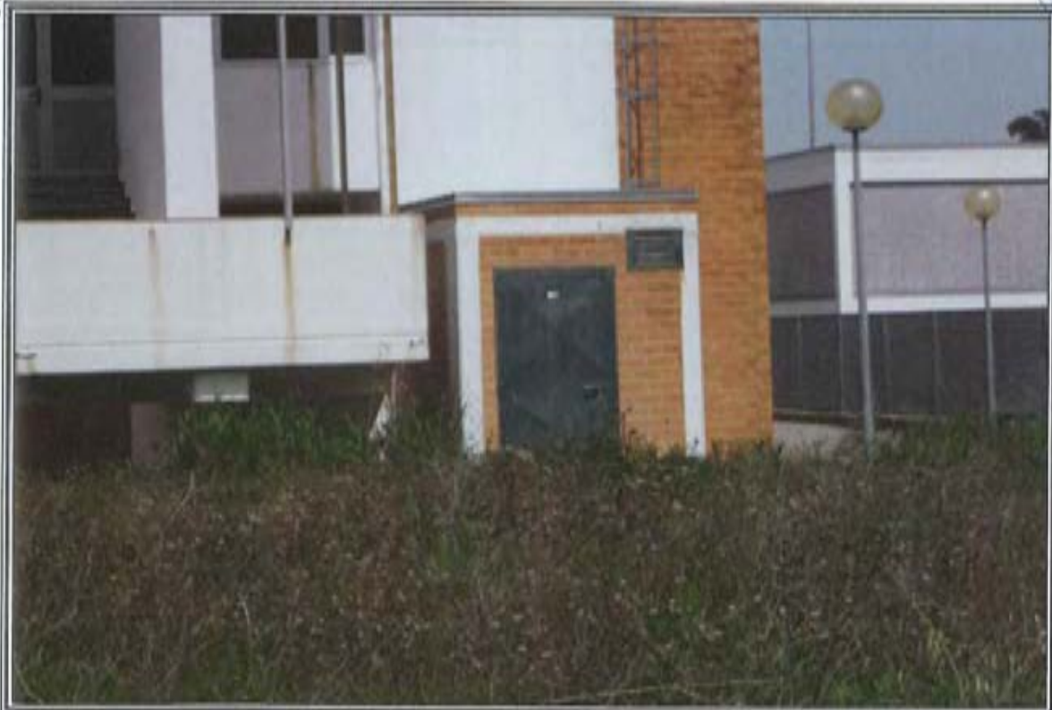
FOTOGRAFIA n. 6: Vista Esterna Area Servizi Generali (SG)
