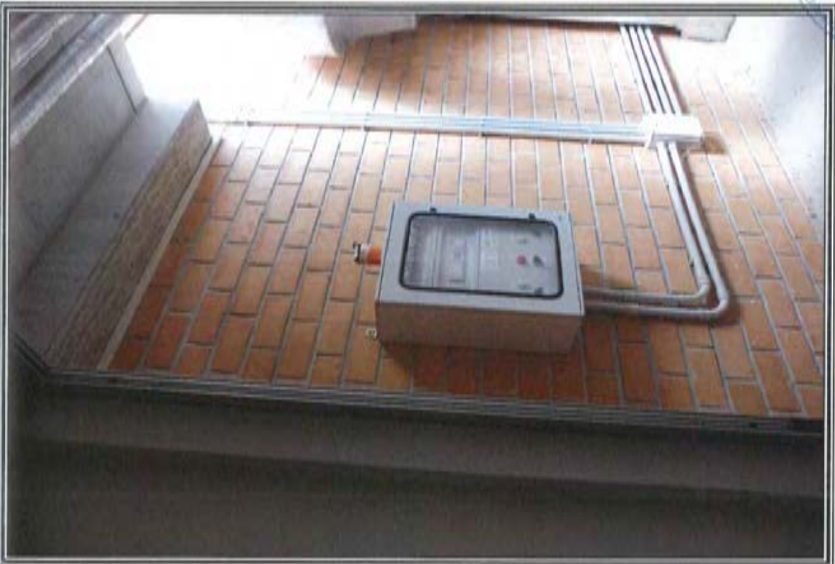
FOTOGRAFIA n. 16: Vista Interna Area Servizi Generali (SG)
