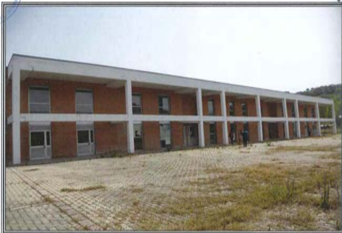
FOTOGRAFIA n. 12: Vista Esterna Area Servizi Generali (SG)
