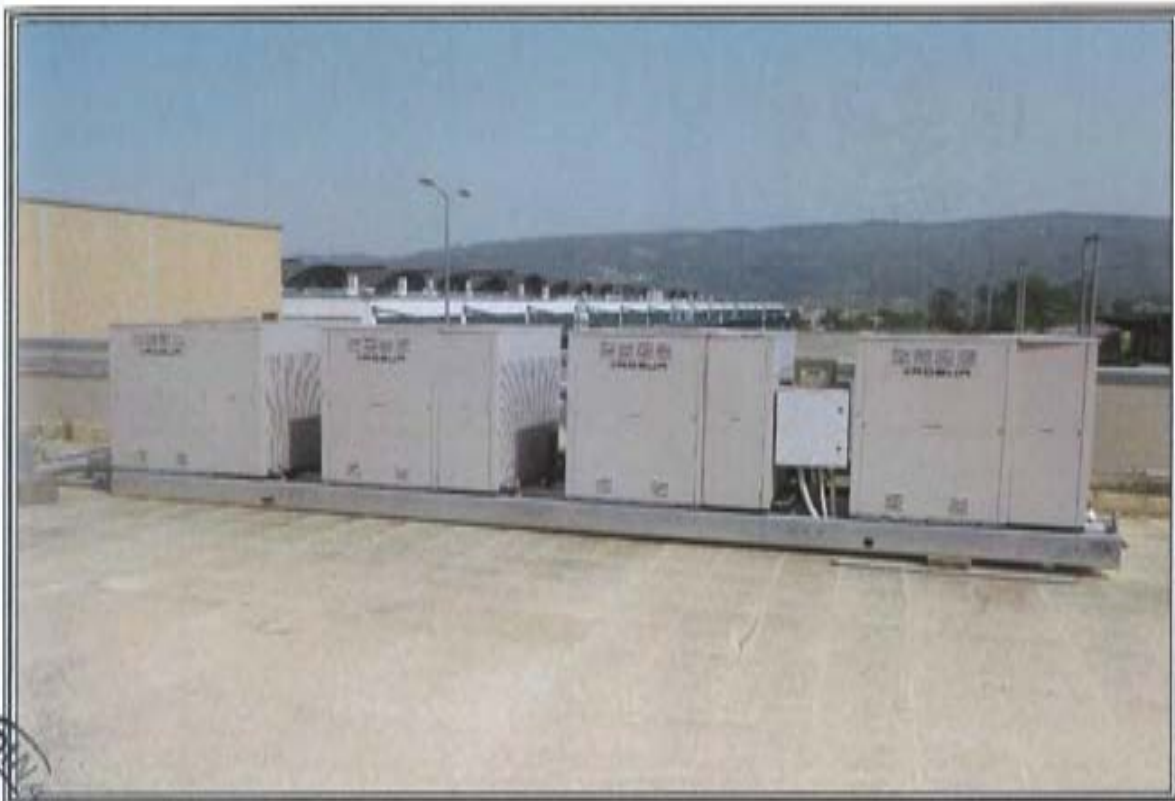
FOTOGRAFIA n. 17: Vista Esterna Magazzini Frigoriferi (MF)
