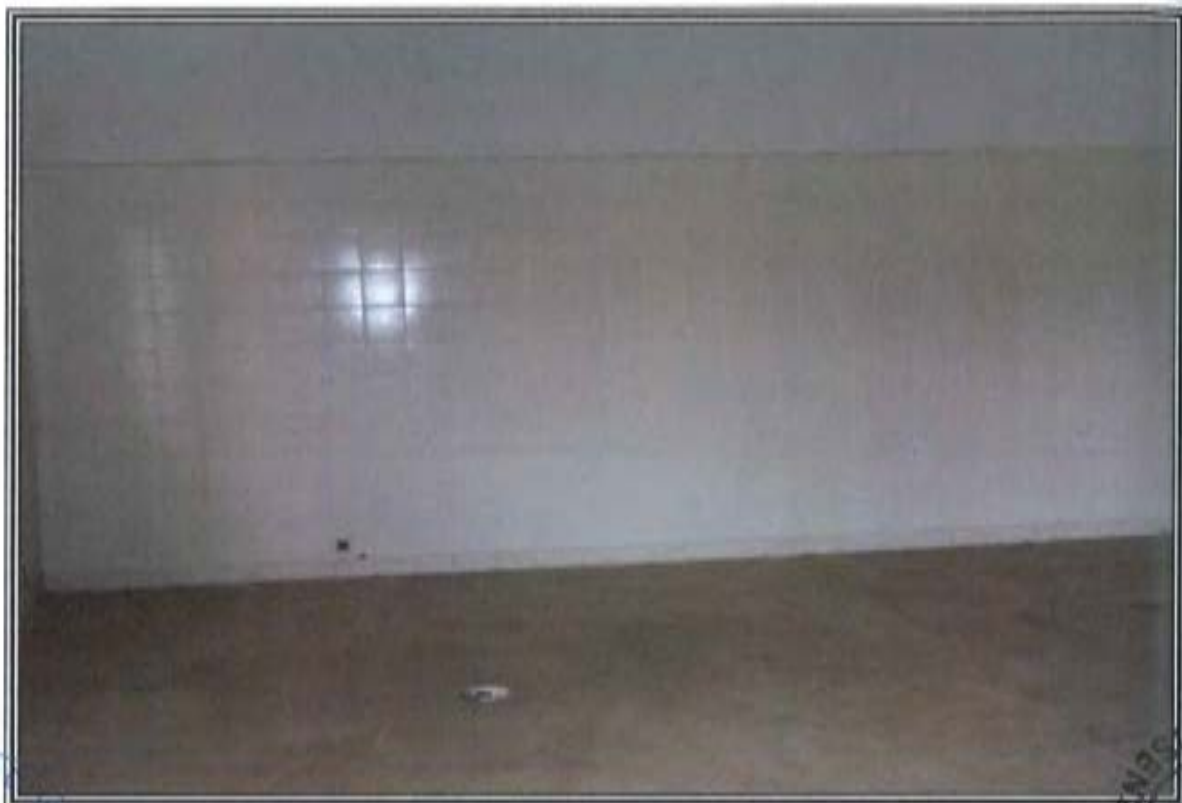
FOTOGRAFIA n. 11: Vista Interna Area Mercato Altre Merceologie (AM)
