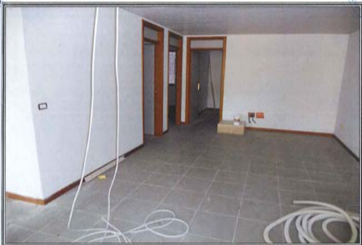
FOTOGRAFIA n. 10: Vista Interna Area Servizi Generali (SG)
