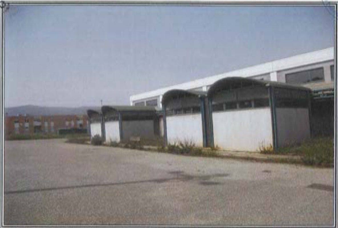
FOTOGRAFIA n. 6: Vista Esterna Area Mercato Altre Merceologie (AM)
