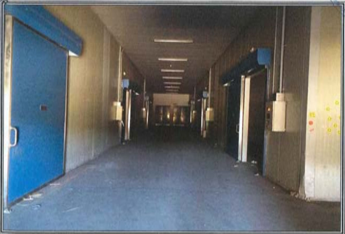
FOTOGRAFIA n. 6: Vista Interna Magazzini Frigoriferi (MF)
