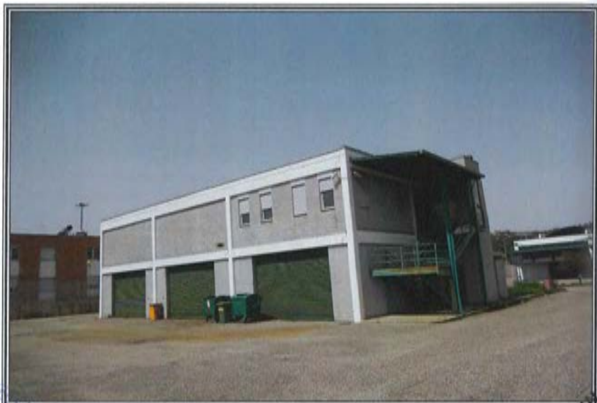
FOTOGRAFIA n. 3: Vista Esterna Area Manutenzione e Pulizie (MP)
