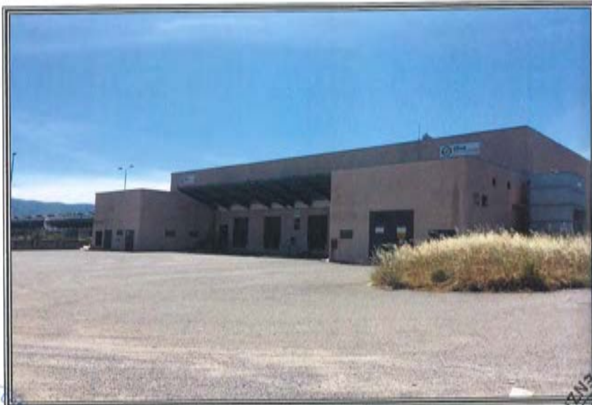
FOTOGRAFIA n. 3: Vista Esterna Magazzini Frigoriferi (MF)
