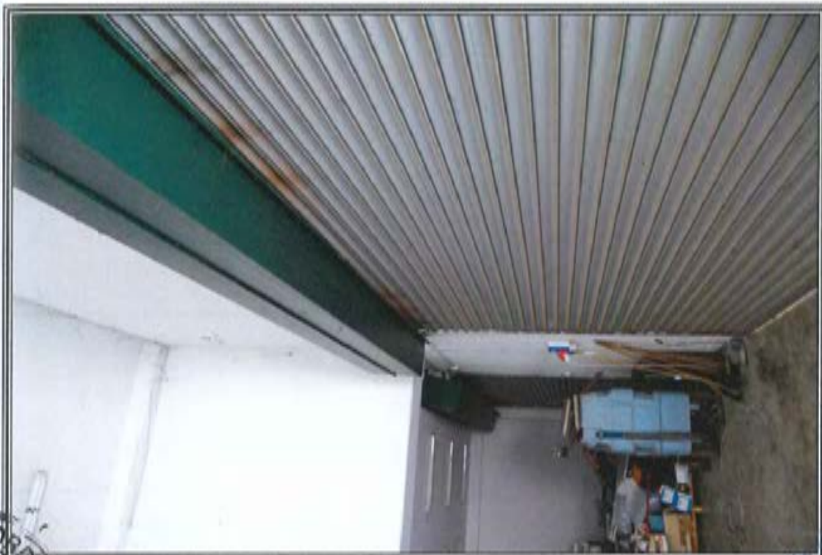
FOTOGRAFIA n. 5: Vista Interna Area Manutenzione e Pulizie (MP)
