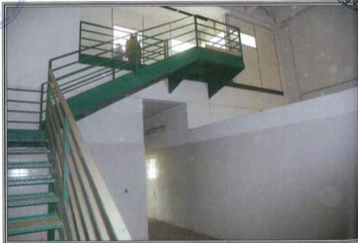
FOTOGRAFIA n. 8: Vista Interna Area Mercato Altre Merceologie (AM)
