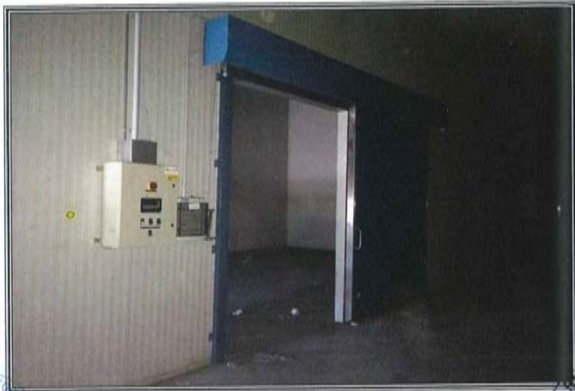
FOTOGRAFIA n. 7: Vista Interna Magazzini Frigoriferi (MF)
