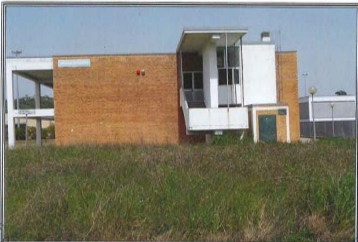
FOTOGRAFIA n. 5: Vista Esterna Area Servizi Generali (SG)
