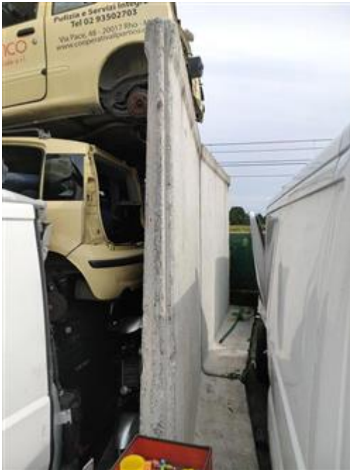
muro in c.a. di separazione con linea ferroviaria
