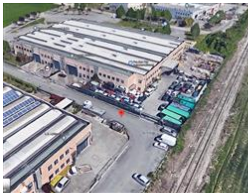
Vista generale edificio
