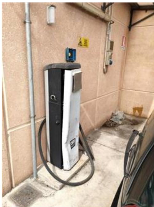
distributore di gasolio non funzionante
