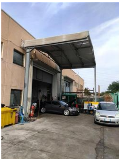
ingresso capannone - tettoia
